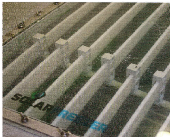
△ Verticale kunststof lamellen. Blijft de warmtepomp energie onttrekken, dan begint zich bij de lamellen ijs te vormen.
