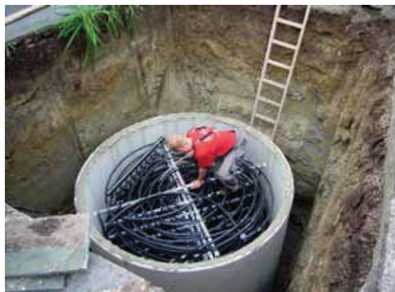
Aanleg van het leidingnetwerk.
