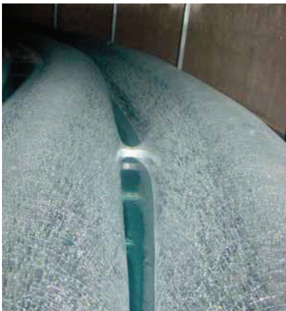
Ijsvorming in de buffer.
