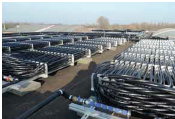
Kunststofslangen vormen een warmtewisselaar.
